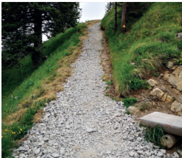
Unterhaltsarbeiten auf dem Streckenabschnitt Hoher Kasten - Staubern.
