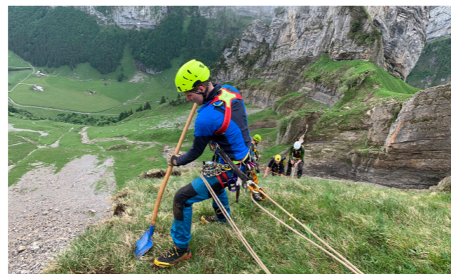
Felsräumung Steckenberg, Rettungskolonne AI, Juni 2022
